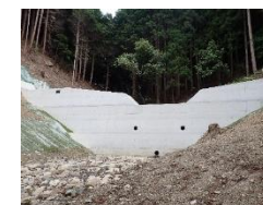
治山ダムの整備
